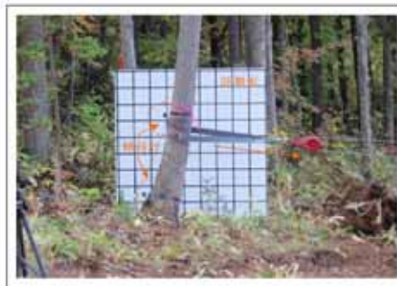
写真3-2.傾斜計と計測板
