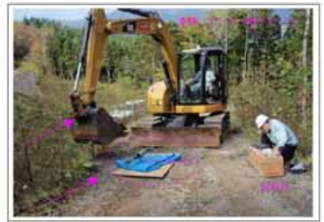
写真3-3.荷重を加える重機
