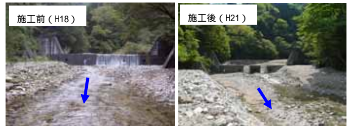
図-4 西松瀬第3号えん堤スリット化前後の状況
