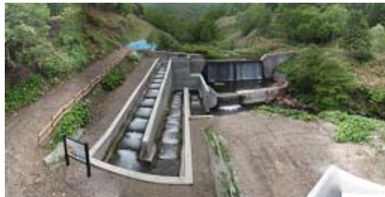
写真 4 施工された提案魚道の全体像と魚道下流端の状態
