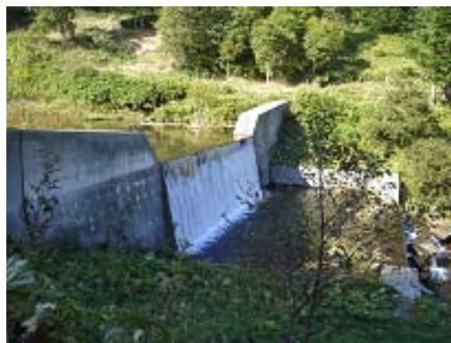
写真1 河口から 150m 上流に位置する治山えん堤とその下流の流況
