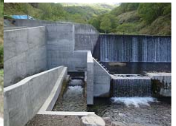
写真 4 施工された提案魚道の全体像と魚道下流端の状態
