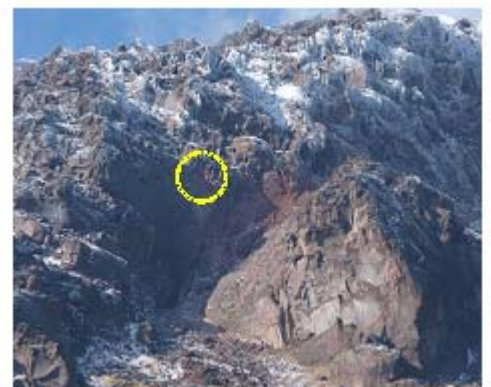
図-1 2008年度（上）及び2009年度（下）に発生した崩落
