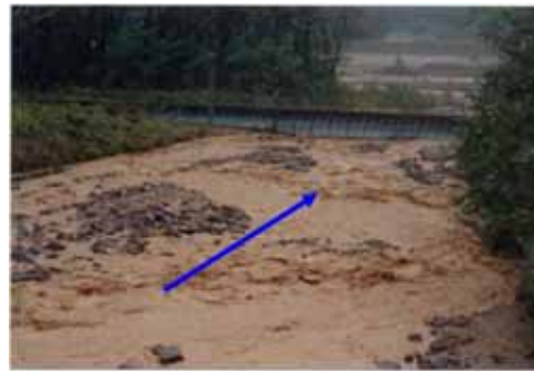
写真-3 平成11年の土石流
