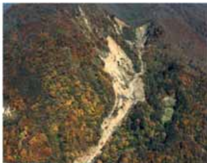
写真-2 濁沢源頭部
