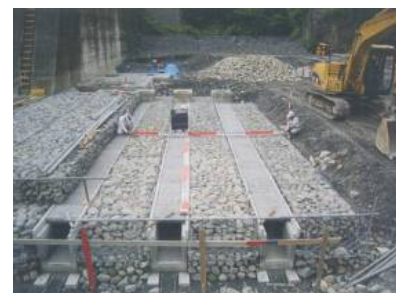
集水路のU字溝とじゃかごの設置状況
