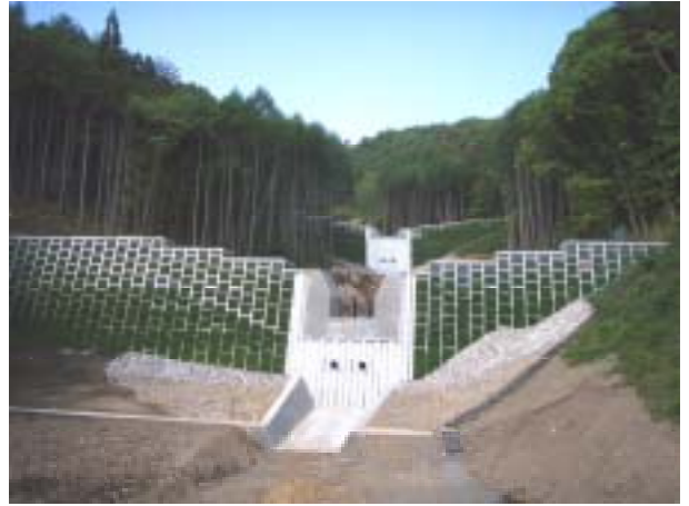
完成した砂防堰堤工 (D.W 工法、流木止設置 小田井沢川)
