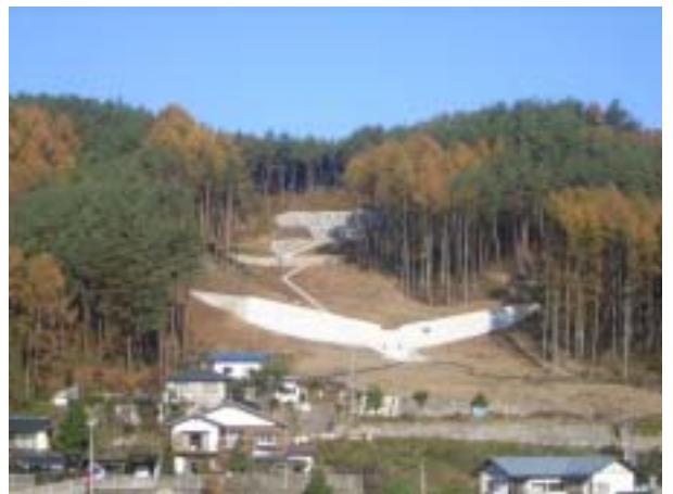
完成した砂防堰堤工 (沢底川右支川)
