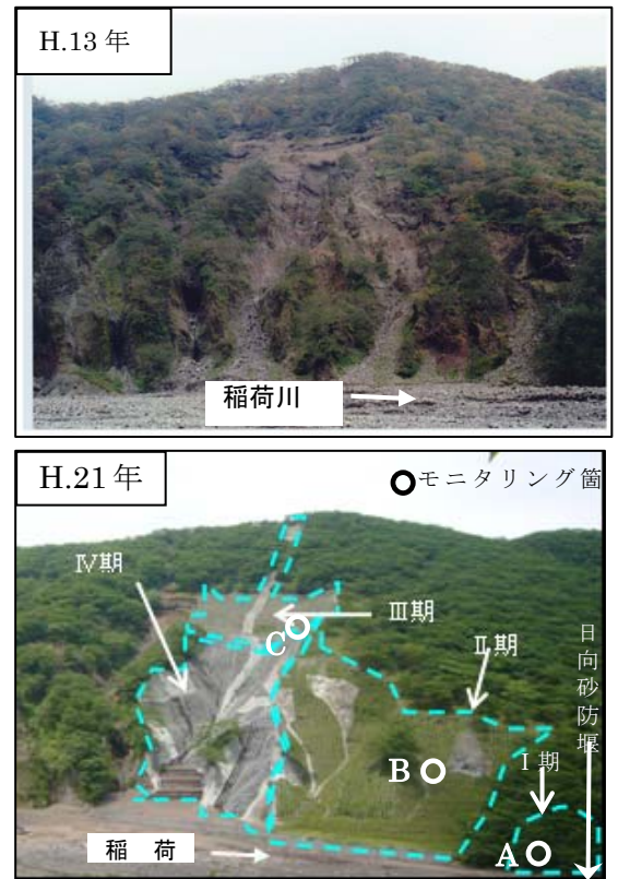
図-4 稲荷川山腹工写真
