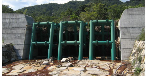
写真-1 透過型砂防堰堤
