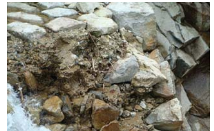
写真-1 粗石コンクリート施設の内部構造
