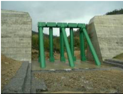
写真 - 1 土石流捕捉前のI型スリットえん堤
