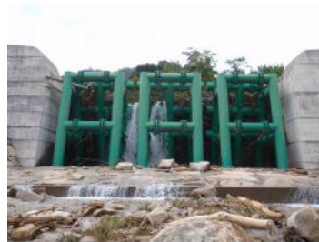
(b)鋼製スリットダムB型
