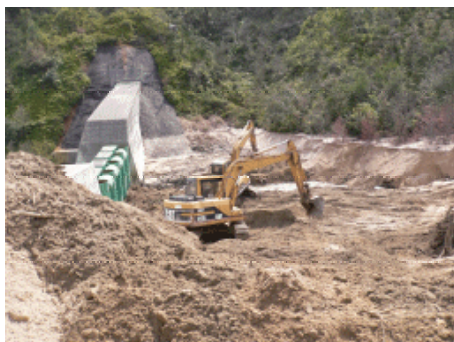
写真 - 3 掘削状況
