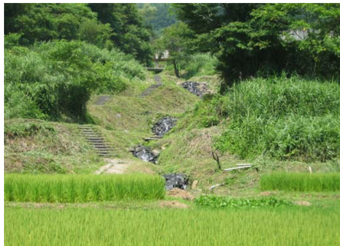
石張水路工（己り地沢最上流部）
