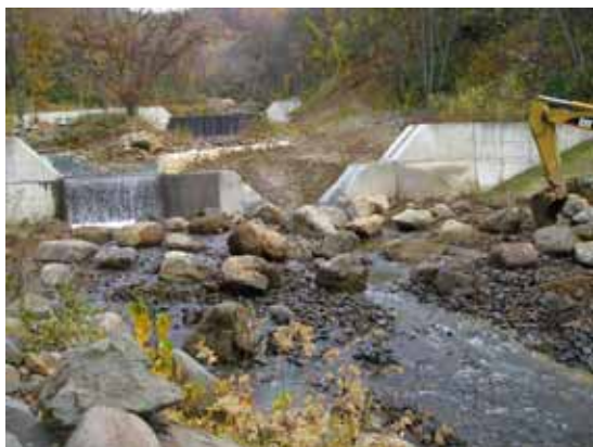
図-1 ダムの切り下げと巨石魚道
