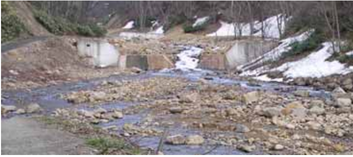
図-3 No.4 より上流の状況
