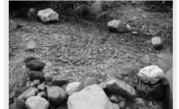
造成した人工産卵場。産卵に適したサイズの礫を河床に敷き詰めて造成する。1箇所あたり3人×30分程度で造成可能。
