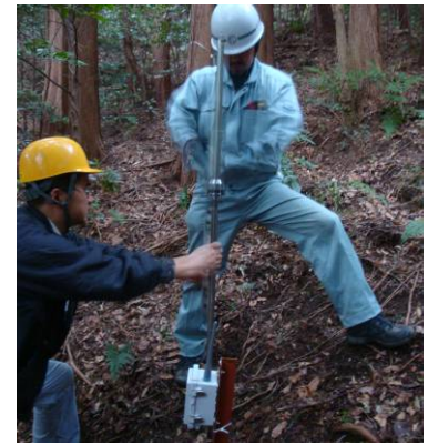
図4 機器の設置作業
