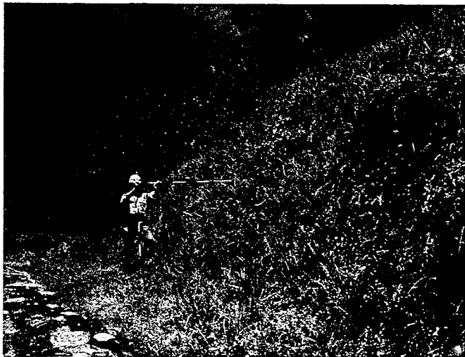
写真3 急傾斜地下端点の状況
