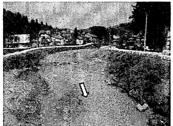
写真-2 ⑤竜光集落内の河道浚渫および堤防嵩上げの状況
