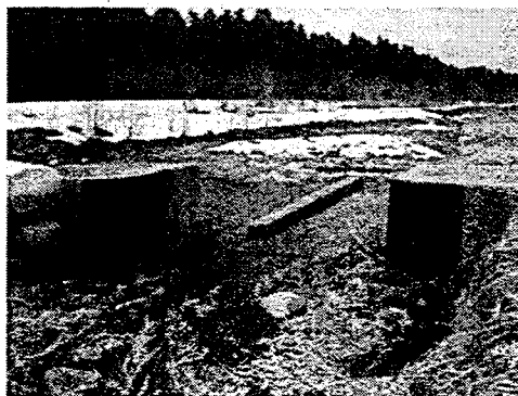
写真-4 ゴム製耐摩耗板を設置したスリット式魚道の現状
