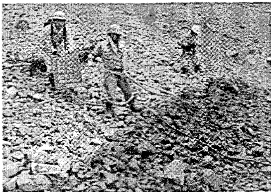
写真1 セメントミルク散布状況
