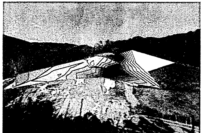
写真-3 各標点の変位量コンタ
