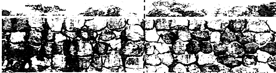
写真-3 右岸側 (石工が施工)
