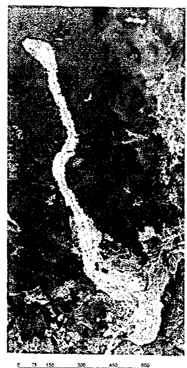
図-4 抽出した崩壊地
