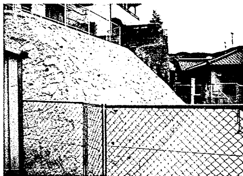
写真-3 対策工完成状況(西片山町地区)
