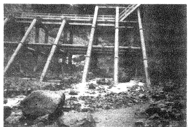
写真 4 2001 年 6 月 30 日の出水後の状態
