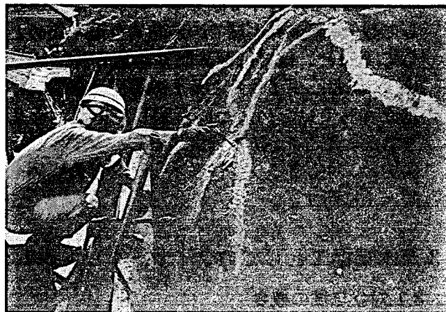
写真3 注入工法適用事例（モルタル吹付のり面）
