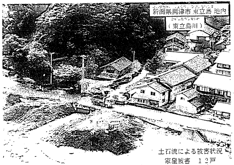
図1 東立島川の土砂流出状況
