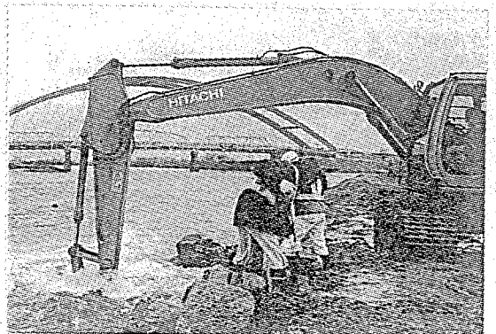
写真-5 採取装置の投入状況
