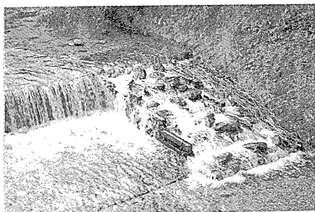
写真 溪床型魚道(落差0.8m)
