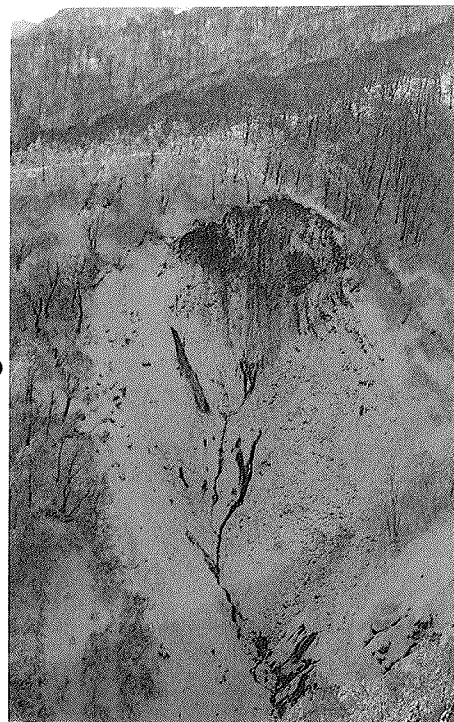
写真 - 1 標高 1300m 付近崩壊斜面
