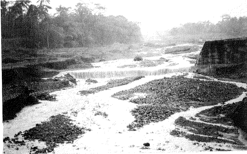
写真-1 Putih川中流部Ngepos付近で1992年1月12日に確認された表流水
