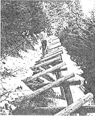
図 - 6 3本1組の群杭工（グライド防止工）により成林（スイス）。
