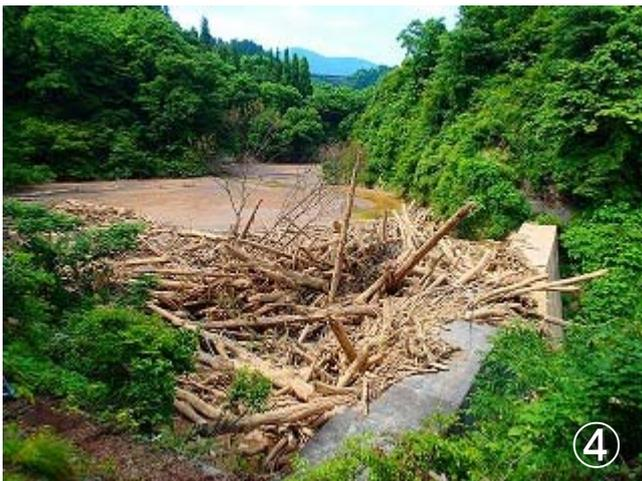
写真④ 桑名川砂防堰堤による土砂と流木の捕捉状況
