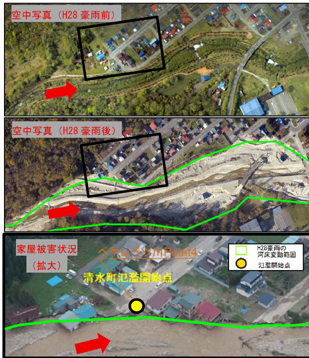
図 2 H28 豪雨前後の空中写真及び家屋被害状況
