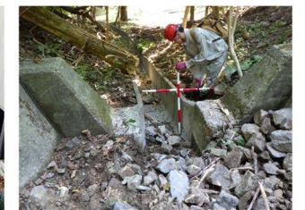
写真② 最下流えん堤直下の流路取り付け部
