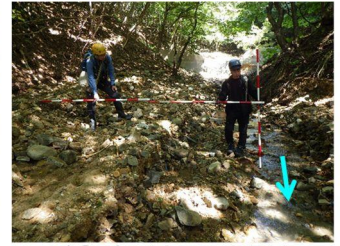
写真② 今回出水による土砂堆積
