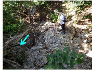
写真③ 最下流えん堤堆砂敷
