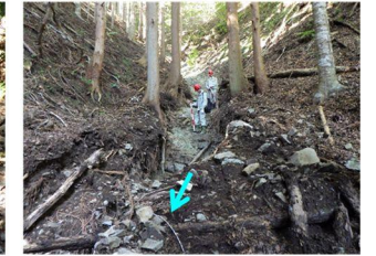
写真④ 溪床堆積土砂の流出状況
