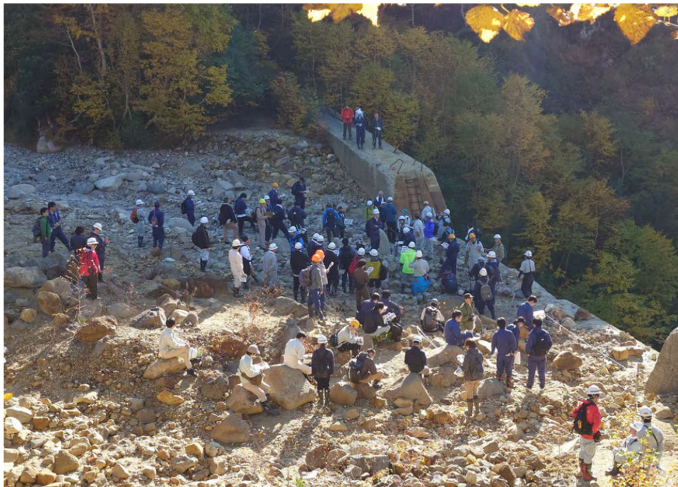
道内最標高に築造した凌雲1号砂防堰堤(S46～S49) にて(水通し標高1,287.5m)
