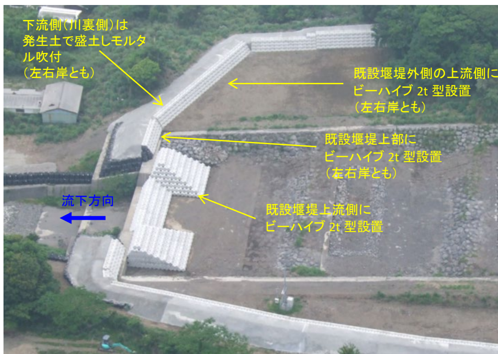
図 4-2 あらかわうち 荒川内 川砂防堰堤（緊急対策時点）
