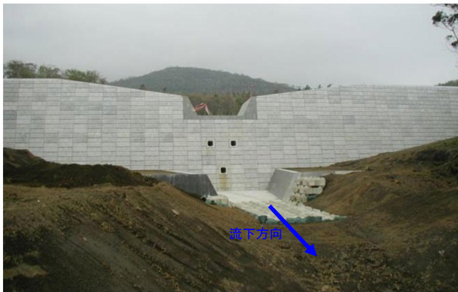
図 4-6 しらみ沢 14 災関砂防堰堤（INSEM 工法）
