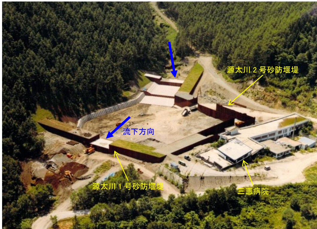
図 4-9 源太川 1 号砂防堰堤 （手前：1982（昭和 57）-1983（昭和 58）年施工）と 源太川 2 号砂防堰堤（奥：1983（昭和 58）-1984（昭和 59）年施工）
