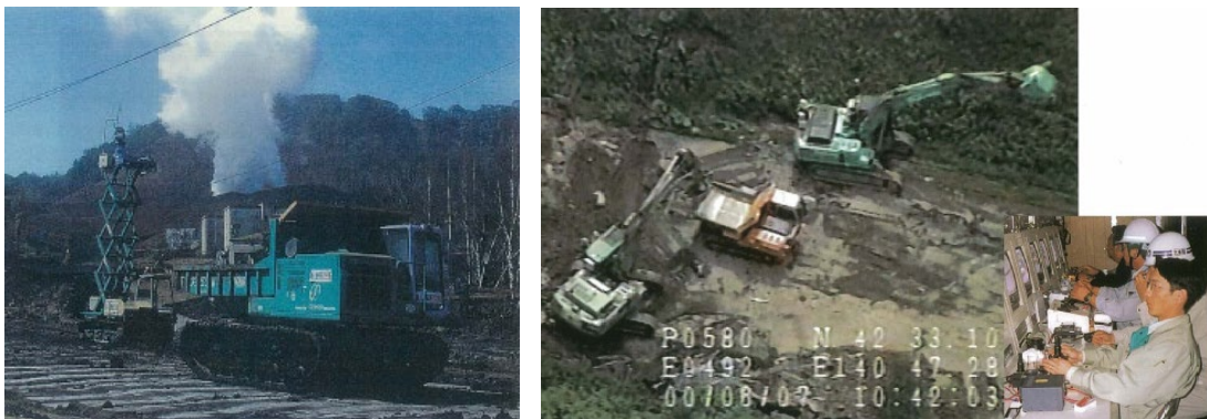
図 4-18 無人化施工機械（左）と無人化施工の作業状況（右）
