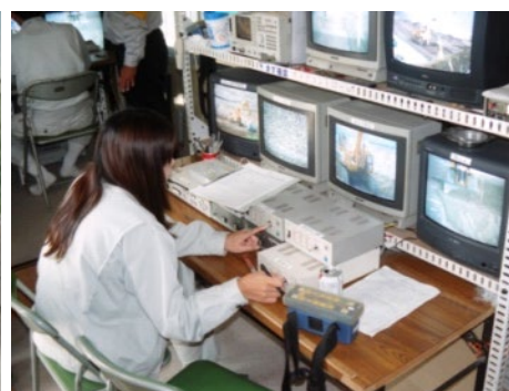
図 4-17 無人化施工の操作室
