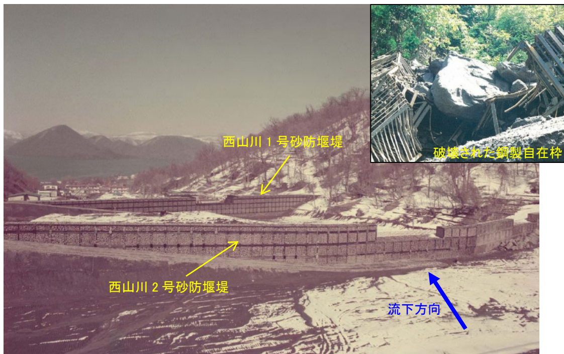
図 4-10 西山川 1 号砂防堰堤 （手前：1978（昭和 53）-1980（昭和 55 年施工）と 2 号砂防堰堤（奥：1977（昭和 52）-1979（昭和 54）年施工）
