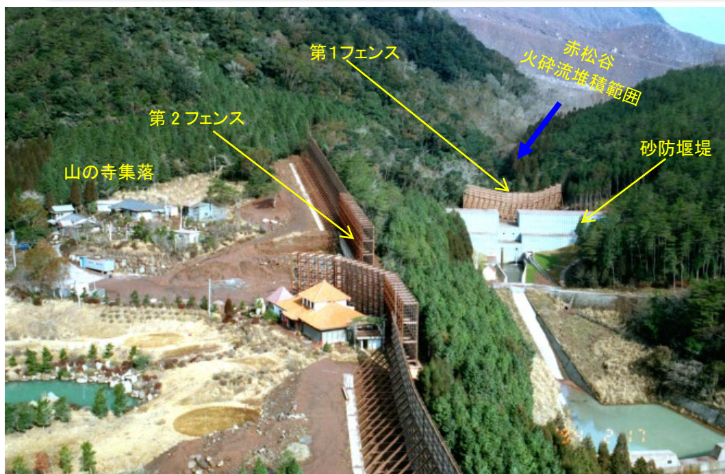
図 4-23 熱風防護柵と砂防堰堤
