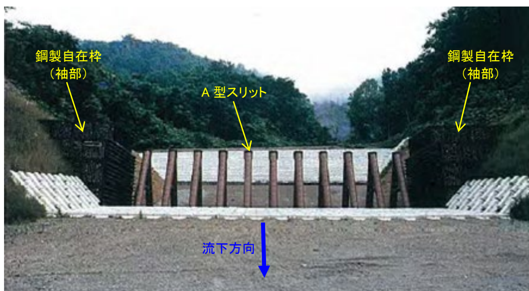
図 4-11 小有珠右の川 2 号スリット堰堤 (1982 (昭和 57) -1983 (昭和 58) 年施工)
