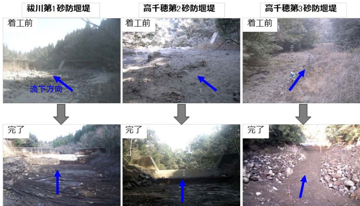
図 4-1 緊急除石の実施前後の状況
