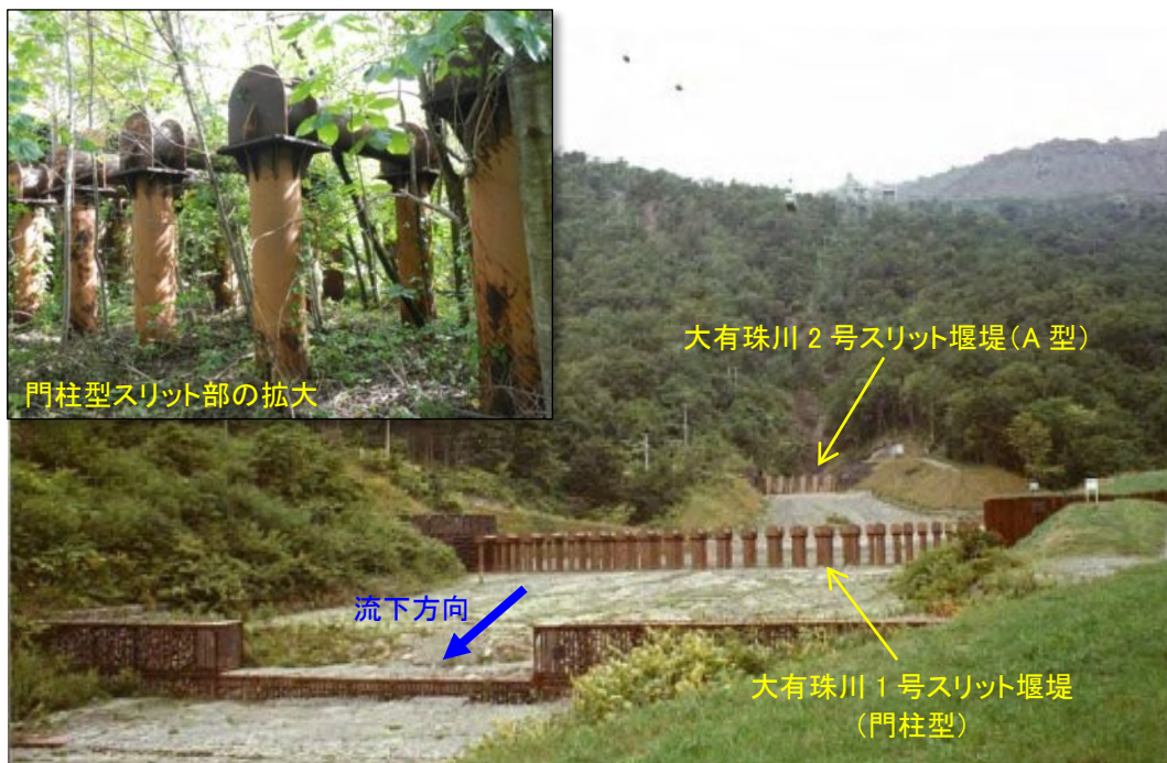
図 4-12 大有珠川 1 号スリット堰堤 (1979 (昭和 54) -1980 (昭和 55) 年施工)
