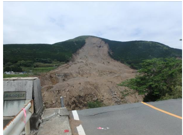
阿蘇大橋地区における大規模崩壊
