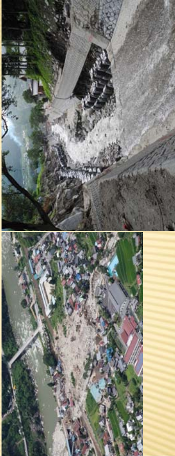
下流側渓流保全工の破損状況
