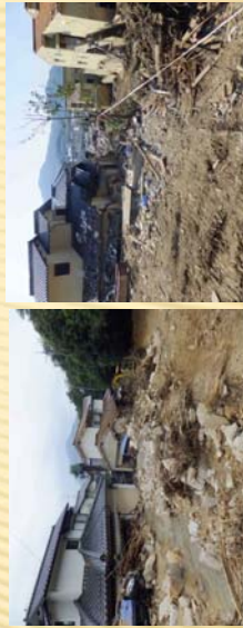
安佐北区可部東6丁目地区の谷すじの家屋の被災状況(この場所を上流の3〜4本の小流による被災状況(勾配は8°程度、花崗岩の巨石と全壊した家屋が確認できる)。
