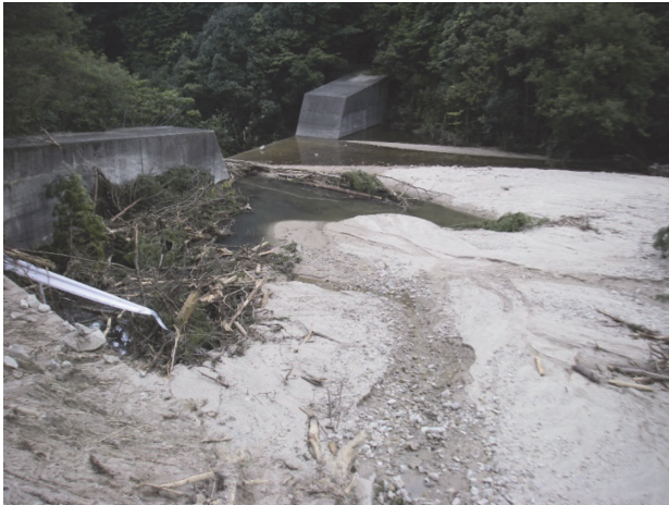
写真-17 砂防堰堤の堆砂状況 (安佐北区大林3丁目, 下ノ谷川)
