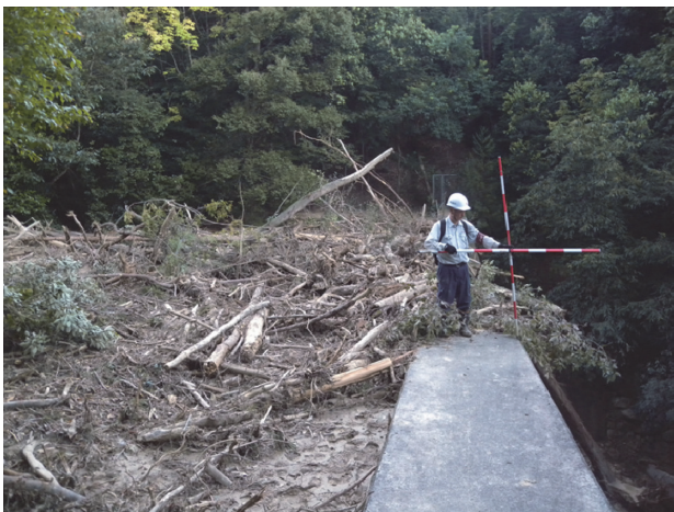
写真-18 根谷川支川85の治山堰堤の堆砂状況
