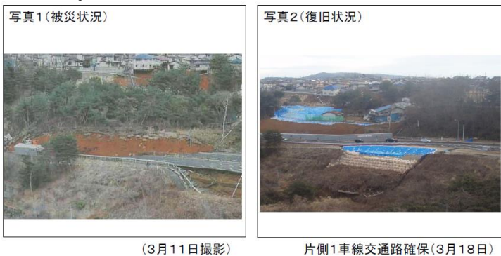
図-5.2 国道4号線福島県福島市伏拝地区復旧前後の状況 9)
