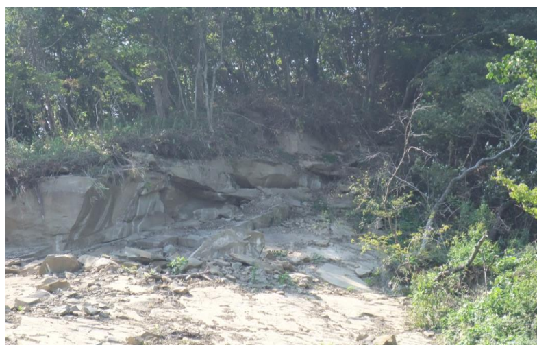
写真-1-1 崩壊地上部
