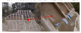
写真-4 法枠内の湧水対策としての適用
