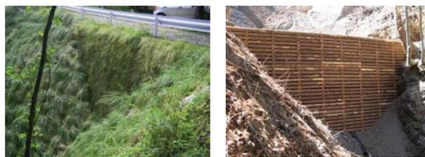
写真-3 壁面のバリエーション(左：緑化、右：間伐材)
