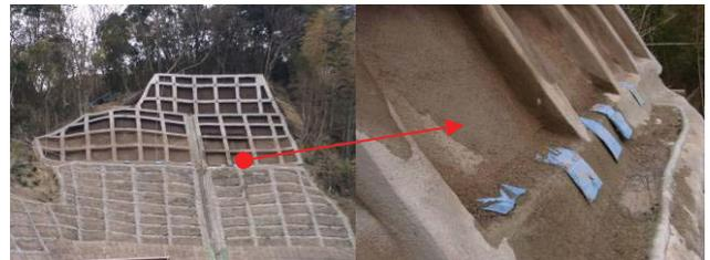
写真-4 法枠内の湧水対策としての適用
