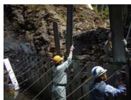
写真-1 U型鋼板差込状況
