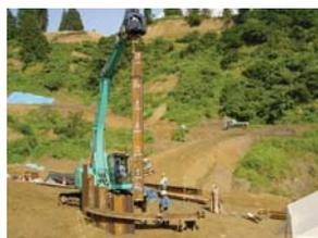
写真-1 鋼矢板基礎施工
