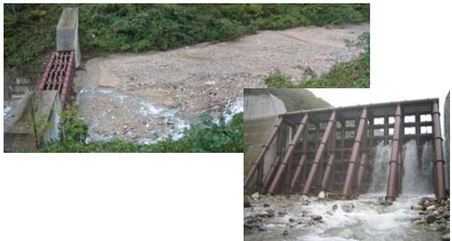
写真2 土石流捕捉事例(菅沼谷第1えん堤)
