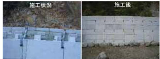
写真-2 カーブ区間の施工状況
