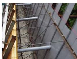
写真-3 擁壁裏型枠
