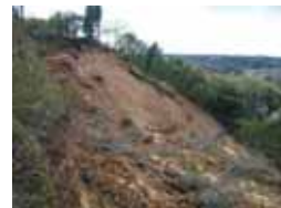
写真-8 藤田地区の滑動層、地質はローム、
