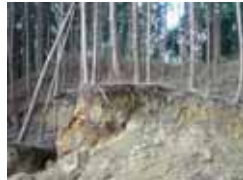
写真-2 浅川地区地すべり滑動地（下部から上部を望む） 古い地すべりの滑動層があり、その少し下部で再活動した。
