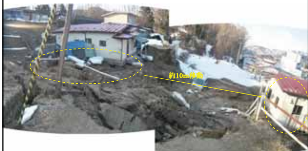
2011年3月11日 二戸市石 所で発生した宅地造成箇所の地すべり
