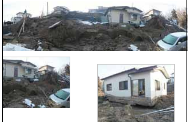
2011年3月11日 二戸市石 所で発生した宅地造成箇所の地すべり
