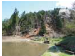
写真-1 浅川地区地すべり全体写真（下部から上部を望む）
