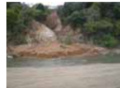
写真-7 藤田地区の崩壊全景、河川の攻撃斜面、崩土は河床部に堆積したが大きな被害はなかった。
