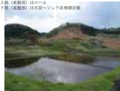
写真-3 押野地区の崩壊全景、崩土は流動化して約200m押し出している。
