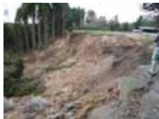
写真-6 八ッ代地区の崩壊地の滑動層、崩の上部は緩土部となっている。 （台地上部に樹を造成した時に切上を盛ったと考えられる）
