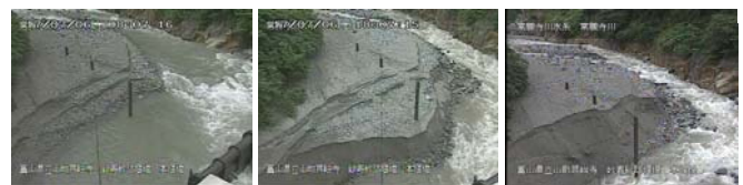
図-3 試験稼働の堆砂敷の状況
