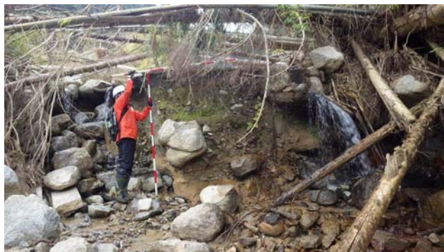
写真-5 河床堆積物の状況（元河床）
