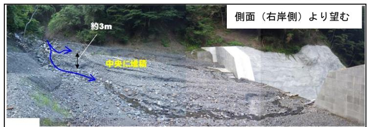
図-4 台風 5 号による堆砂状況
