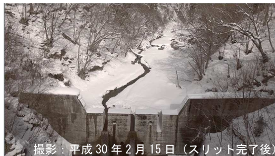
写真-1 対象砂防堰堤の外観と周辺地形
