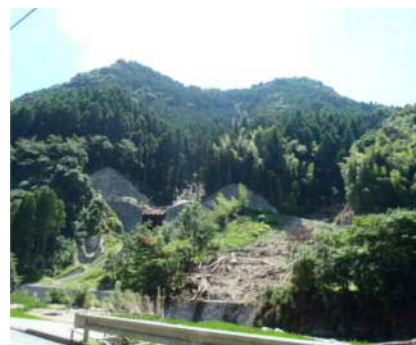
写真-6 堰堤左岸側の土砂・流木流出状況
