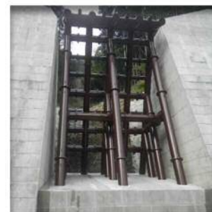
写真-3 完成時の状況
