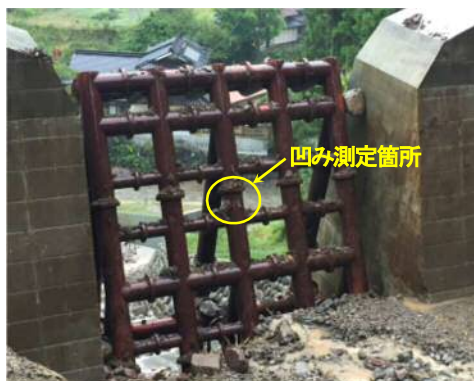
写真-7 除石後の状況
