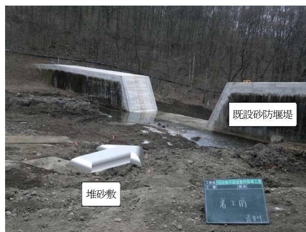
写真-1 施設の現況(上流堆砂域: 着工前)
