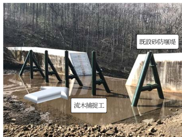
写真-2 流木捕捉工設置後（上流堆砂敷）
